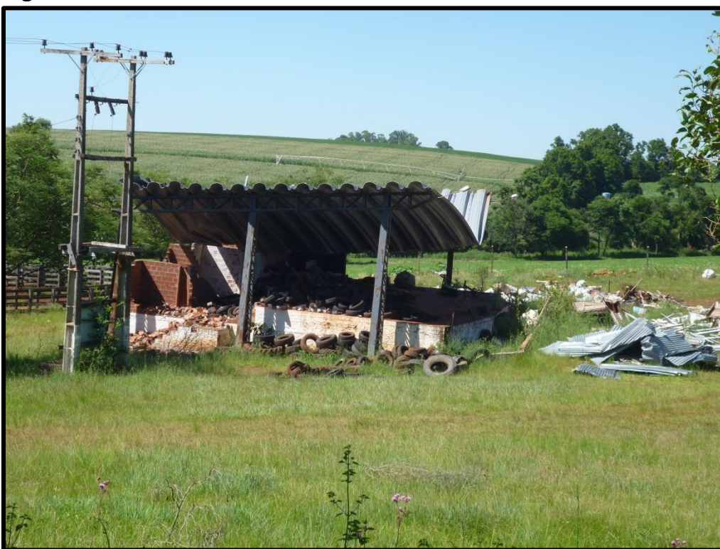
Figura 23: Área de transferência de resíduos sólidos.
