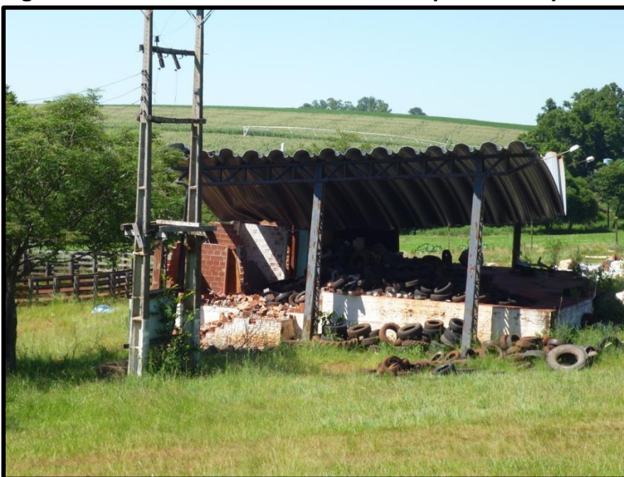
Figura 28: Local de armazenamento temporário de pneus inservíveis.
