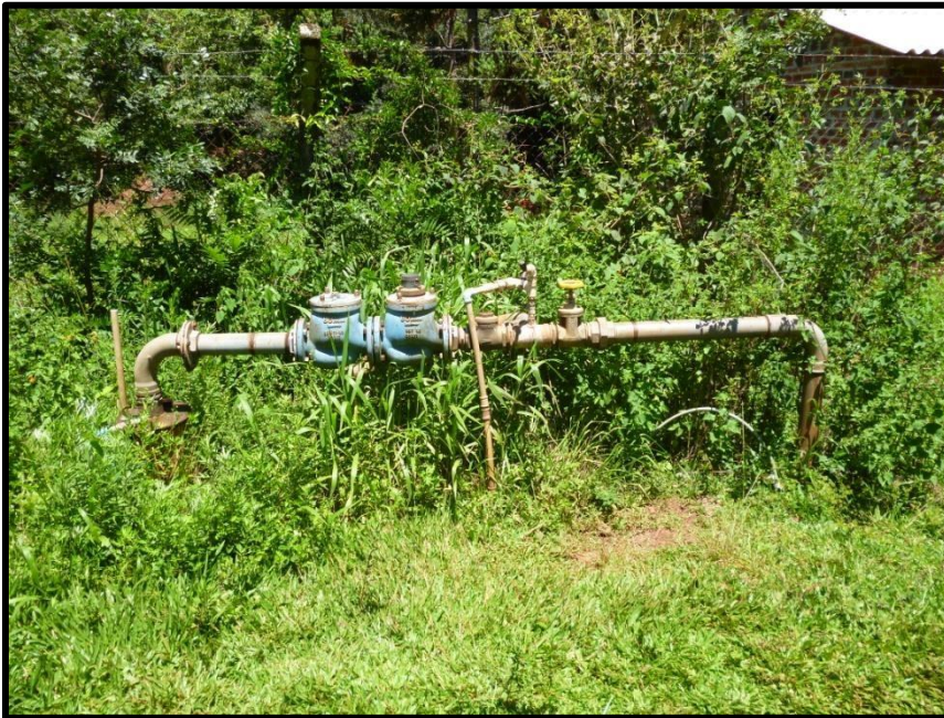
c) Poço PJ02
